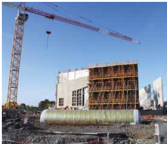
Les travaux ont débuté le 27 mai 2011.
